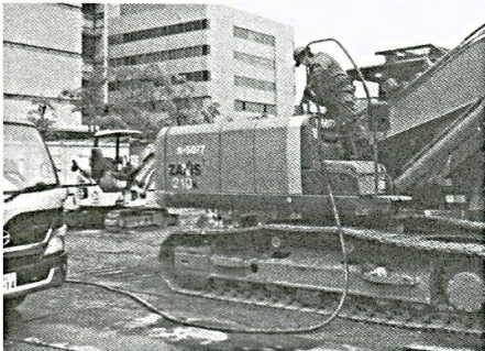
現場給油の様子
