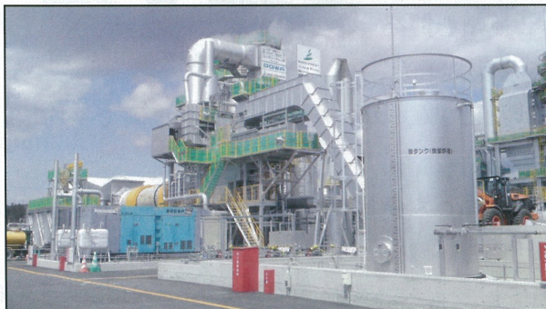
気仙沼災害廃棄物処理業務現場 焼却炉 (宮城県)
