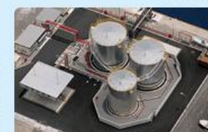
鹿児島油槽所
