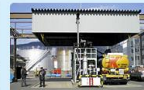
佐世保油槽所
