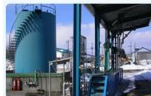
中標津油槽所
