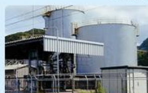
長崎漁港油槽所
