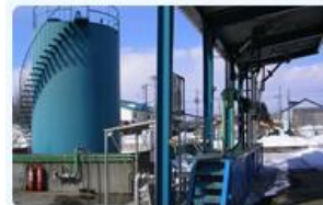
中標津油槽所
