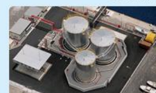
鹿児島油槽所
