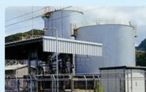
長崎漁港油槽所
