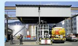
佐世保油槽所
